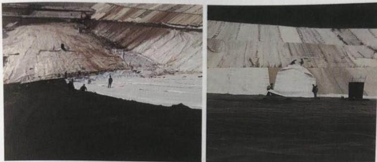
图 5-13 现场膜铺设示意图
